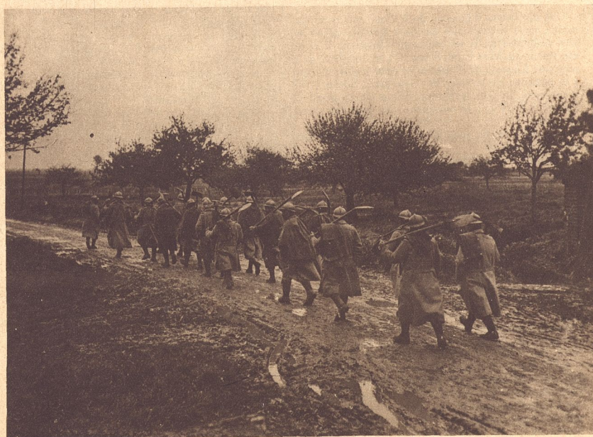
Ces soldats vont effectuer des travaux de terrassement.
