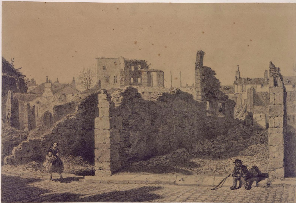
Entrée de la rue des Arènes.
