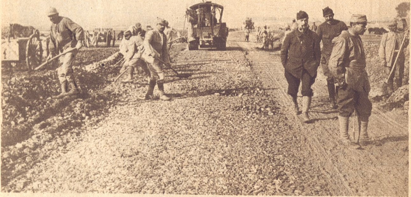
Empierrement d'une route sur le front de la Somme.
